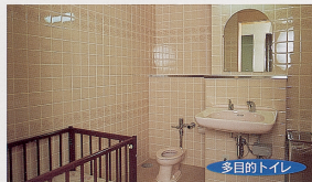
多目的トイレ
